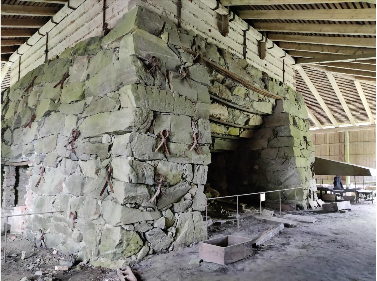
Kuva 15: Masuunin massiivinen harmaakivijalusta, jonka yläpuolella on maalla täytetty hirsikehikko.
