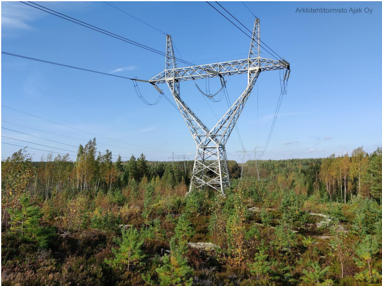
Kuva 9: 400 kV:n Seinäjoki-Uvila-linjan voimajohtopylväs ja Ulvilan sähköasemalta pohjoista kohti kulkeva korkeasta puustosta raivattu voimajohtoalue.
