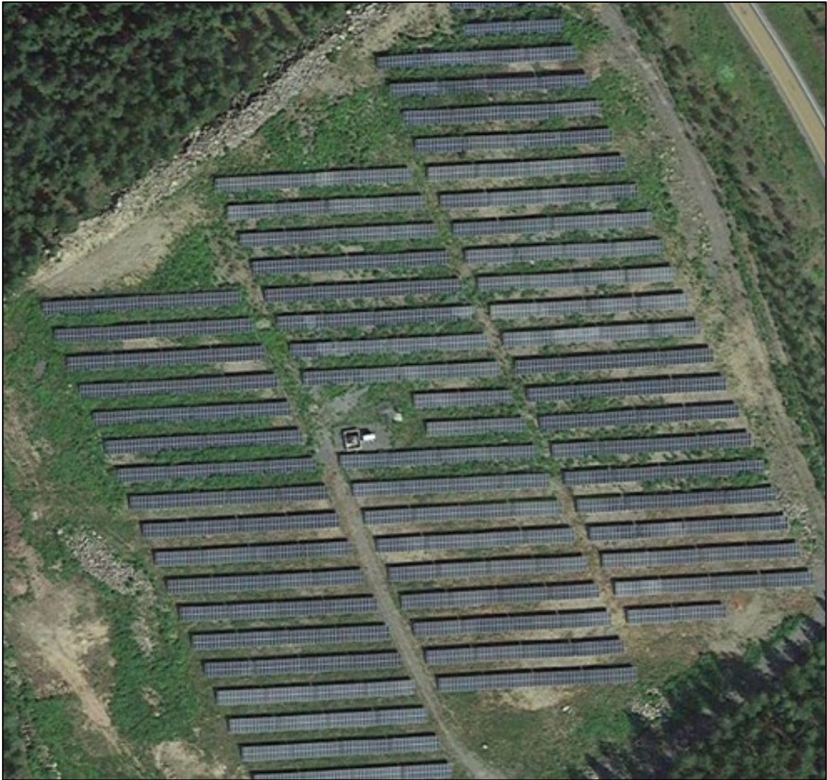
Kuva 25. Ilmakuva Lempäälän energiayhteisön aurinkovoimalasta. Kentän koko on 2,5 ha (Kuva: Google Maps, 2022).
