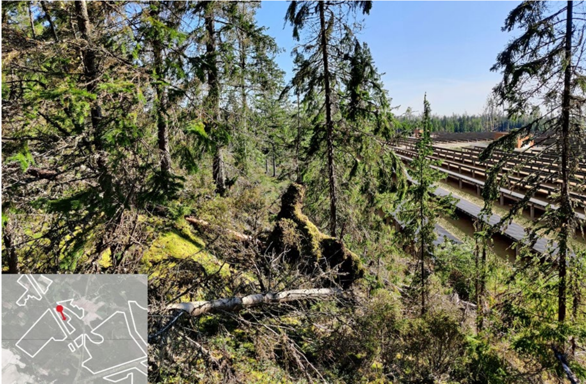
Kuva 37. Näkymä ge2-alueelta kaakkoon paneelialueelle D aurinkovoimalan valmistuttua.
