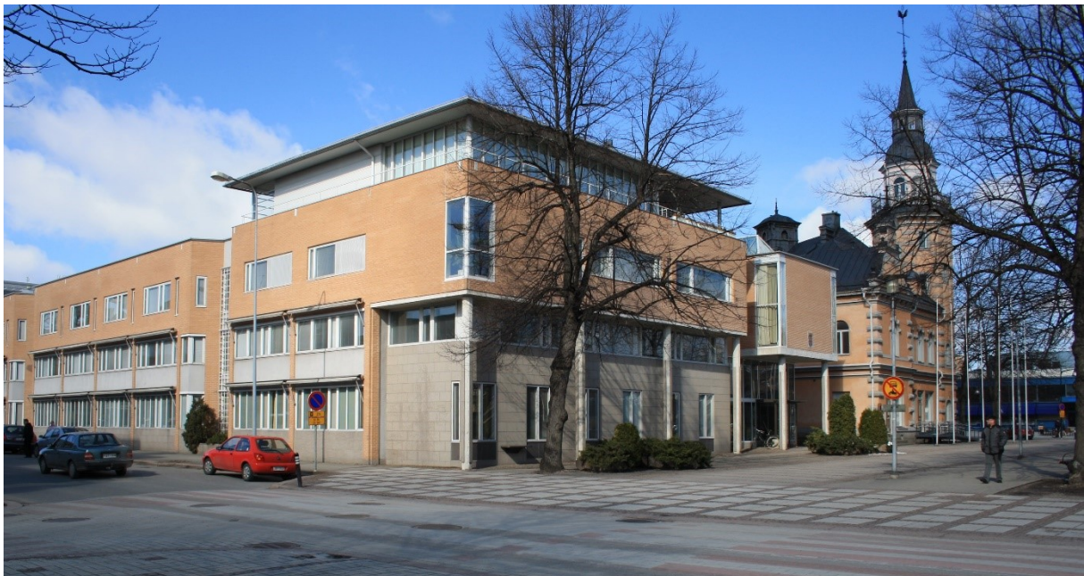
Kuva 56 Rauman kaupungintalon laajennusosan ovat suunnitelleet arkkitehdit Eric Adlercreutz ja Hasse Hägerström vuonna 1992.
