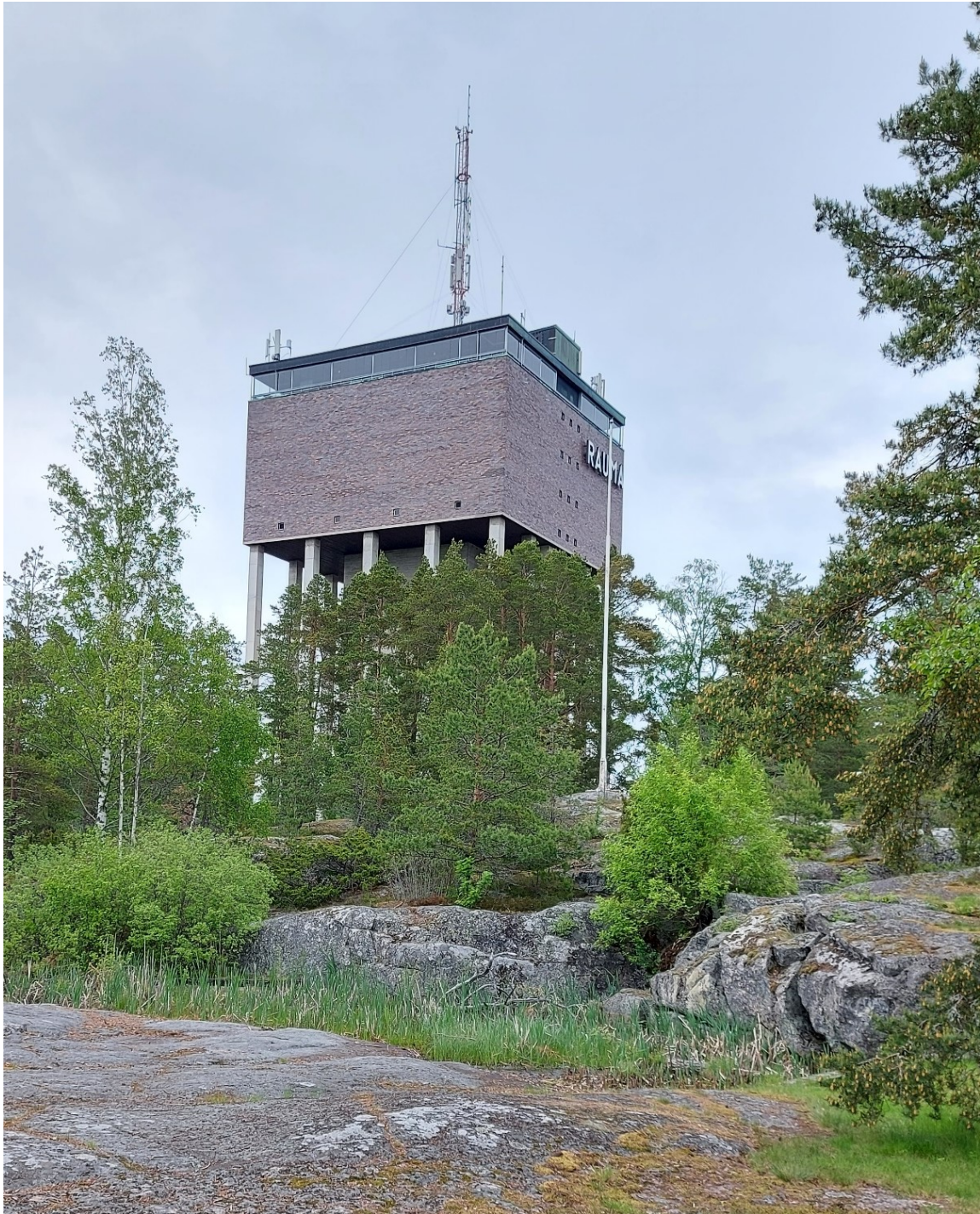
Kuva 35 Rauman vesitorni on rakennettu vanhan vesitornin ympärille uudelleen 1960-luvulla.
