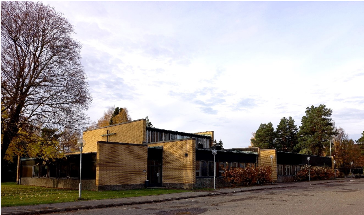
Kuva 6 Arkkitehtuuritoimisto Martaksen suunnittelema Harjavallan seurakuntatalo on valmistunut vuonna 1965. Rakennukseen on tehty muutoksi vuonna 1999 (Tuula Linkola-Marimo, arkkitehti SAFA).
