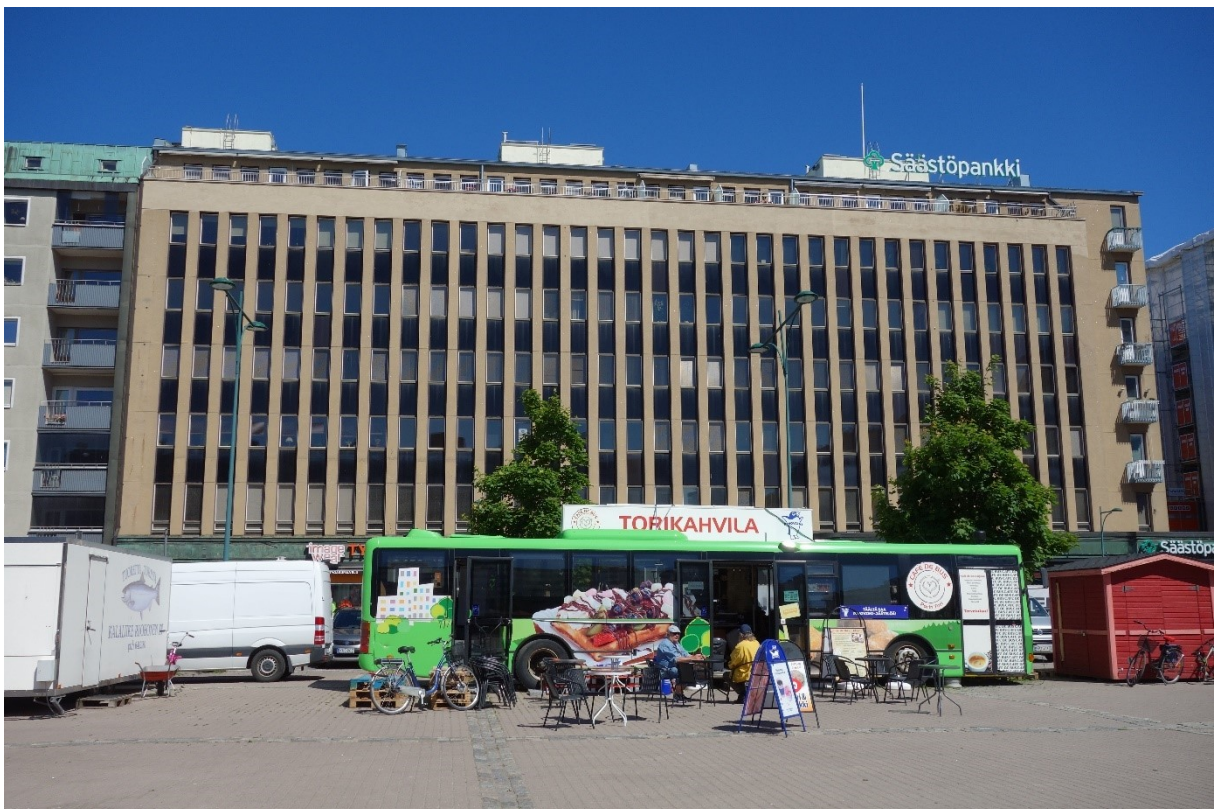
Kuva 54 Monumentaalisen pankkirakennuksen Porin torin laidalla on suunnitellut Tampereen kaupunginarkkitehti Bertel Strömmer vuonna 1954.
