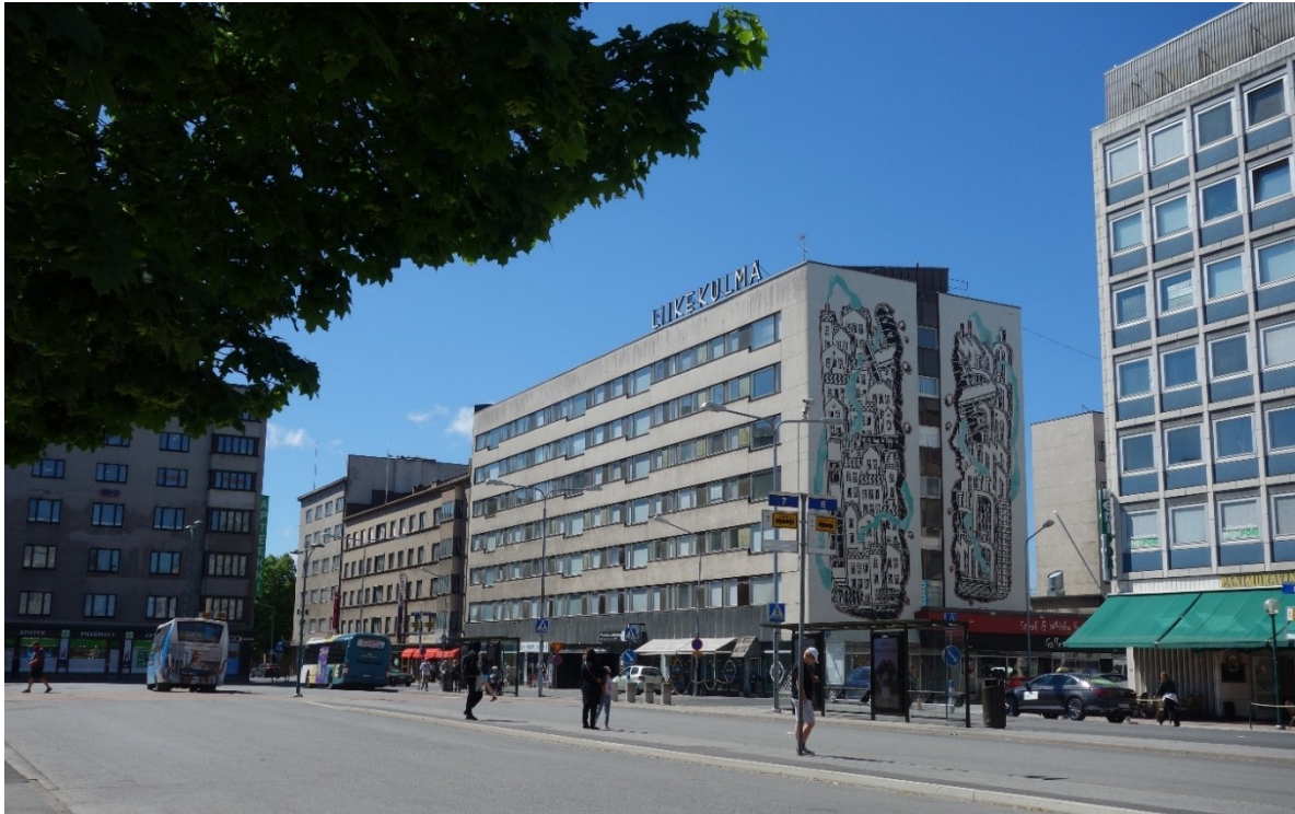
Kuva 53 Porin torin ympäristön rakennuskanta on modernia. Esimerkiksi Liikekulma Antinkadun ja Gallen-Kallelankadun kulmassa on valmistunut vuonna 1960. Suunnittelijoina toimivat arkkitehdit Keijo Ström ja Olavi Tuomisto.
