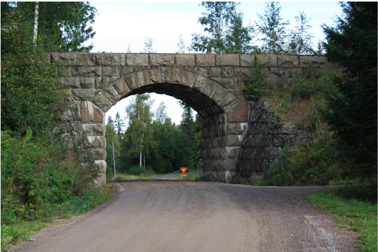
Kuva 41 Rautatiesilta Kankaanpään Veneskoskella.
