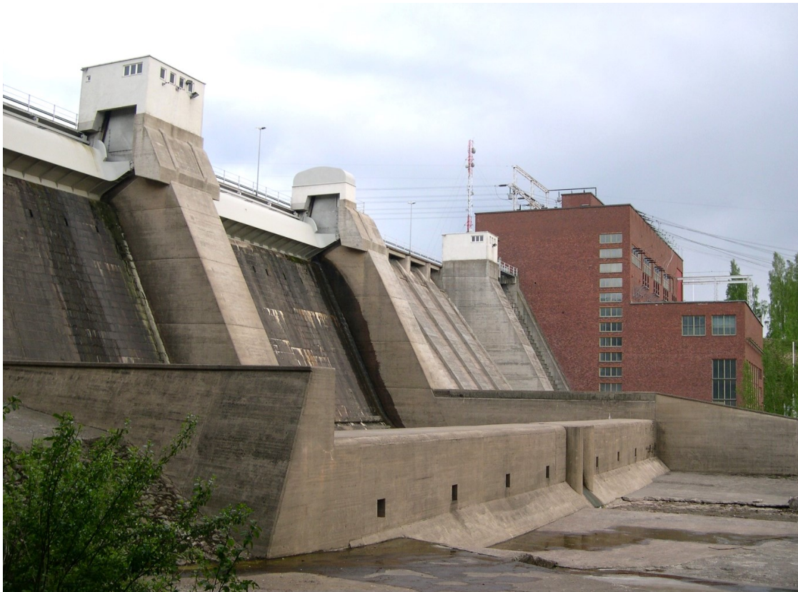
Kuva 15 Erik Bryggmanin suunnittelema Harjavalan vesivoimalaitos on valmistunut 1930-luvulla.
