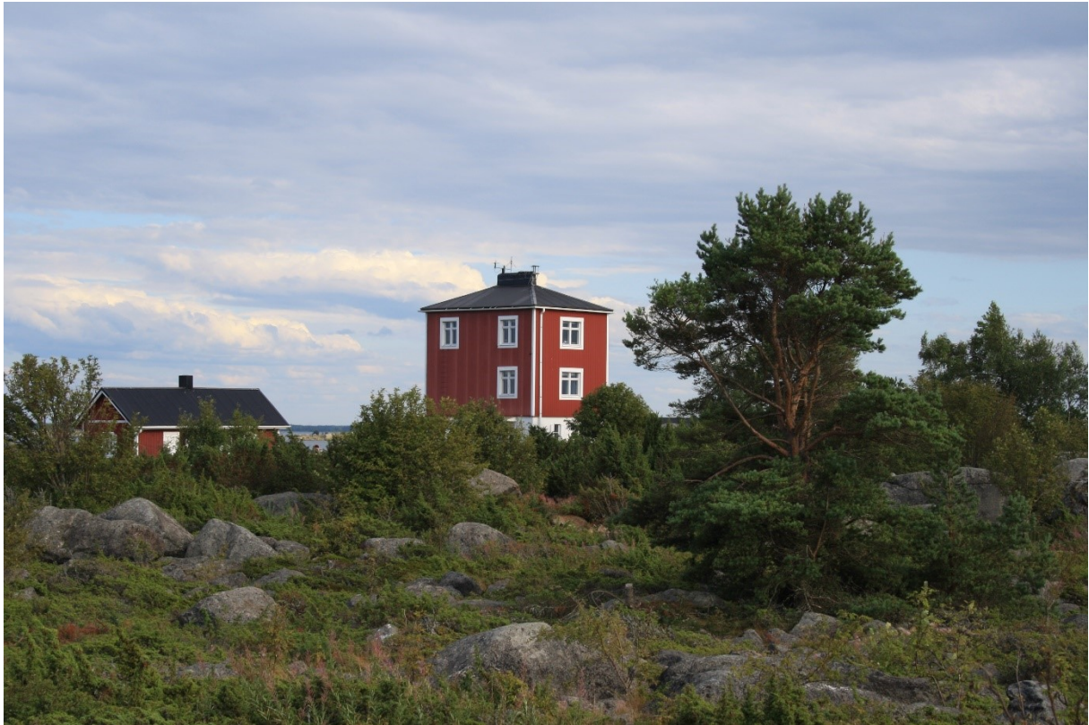
Kuva 110 Ouraluodolla on vuonna 1937 rakennettu luotsiasema.
