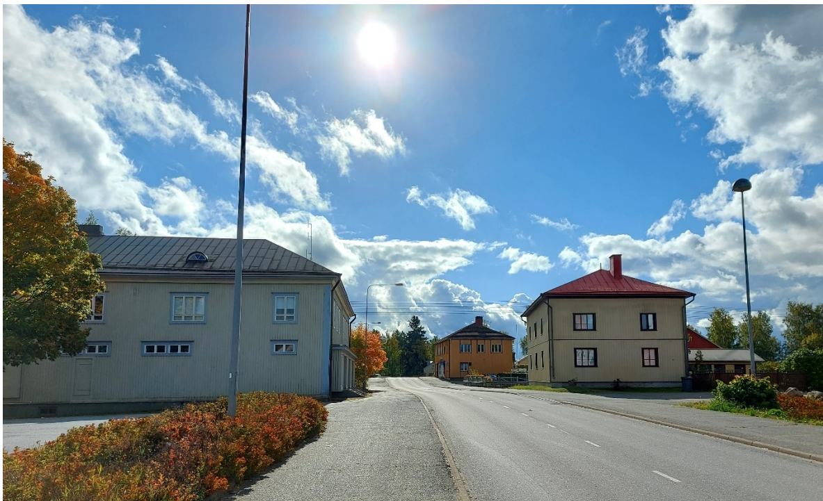
Kuva 19 Euran Panelian kirkonkylässä vanhat liikerakennukset muodostavat edustavan kokonaisuuden.
