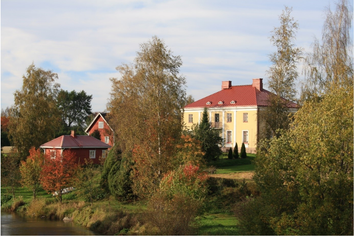
Kuva 25 Vuolteen kartanon päärakennus on rakennettu 1920-luvulla.
