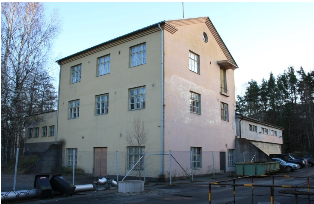
Kuva 34 Rauman vanha vesilaitos on maakunnan vanhin jäljellä oleva vesilaitos.
