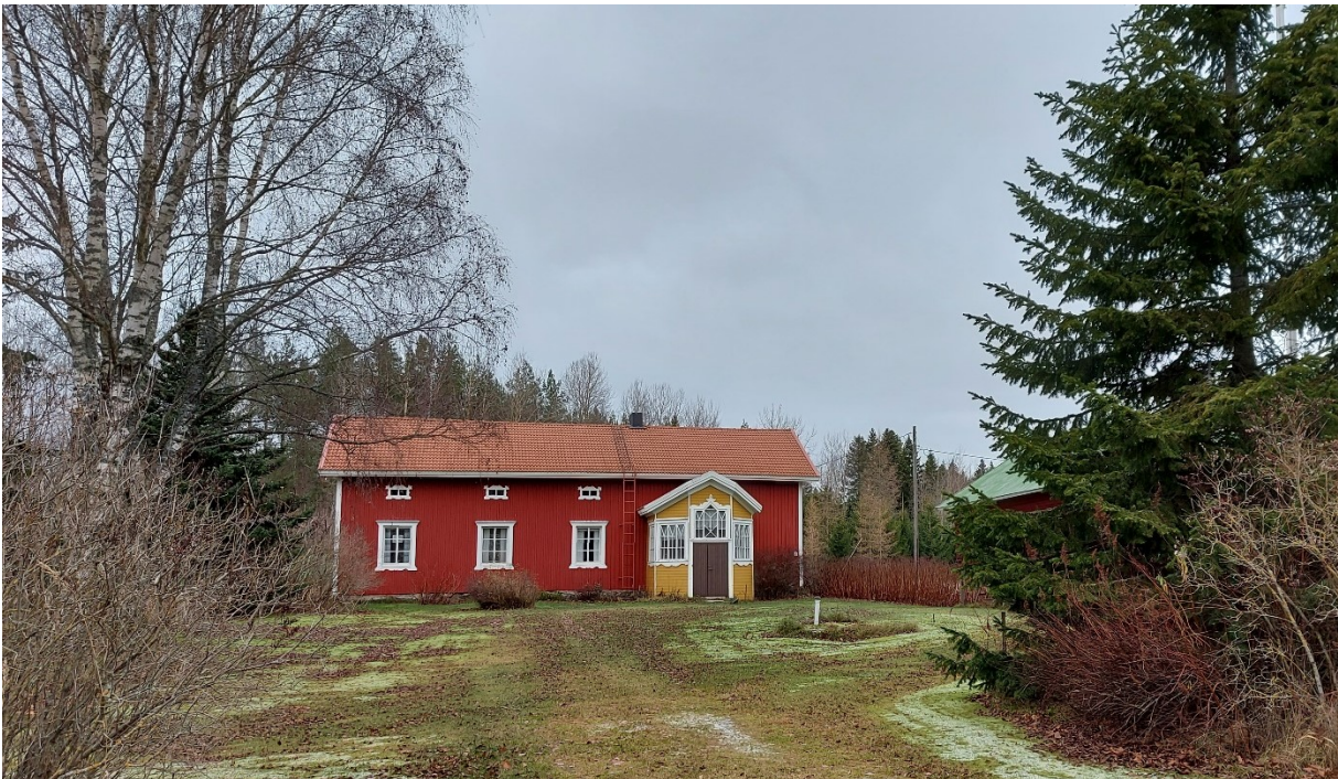
Kuva 22 Merikarvian kylässä on säilynyt paljon rannikkoseudulle tyypillistä rakennusperintöä. Tämä talo on Riispyyn kylässä.
