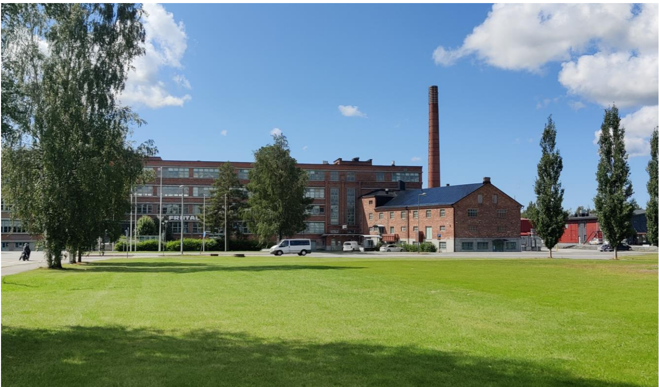
Kuva 3.7. Friitalan tehdas idästä katsottuna. Kuva kohdekäynniltä, 2023.
