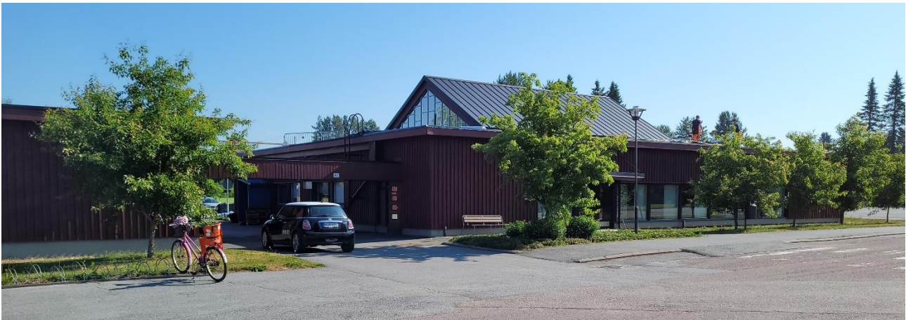
Kuva 4.143. A-rakennus etelästä katsottuna. Vasemmalla B-rakennus ja katos.
