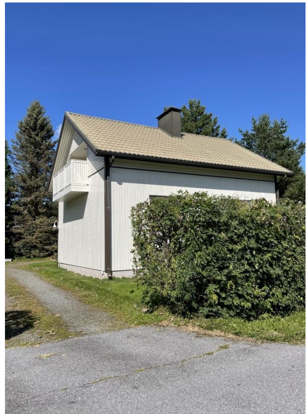
Kuva 4.61. Talo Veljestien ja Finnepäkintien risteyksessä. Parveke on lisätty talon länsipäätyyn.
