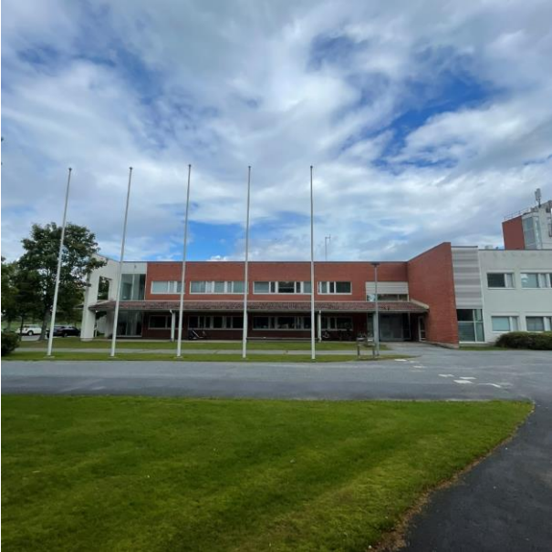
Kuva 4.128. Päiväkodin siipi ja etupiha. Näkymä Siltatieltä.
