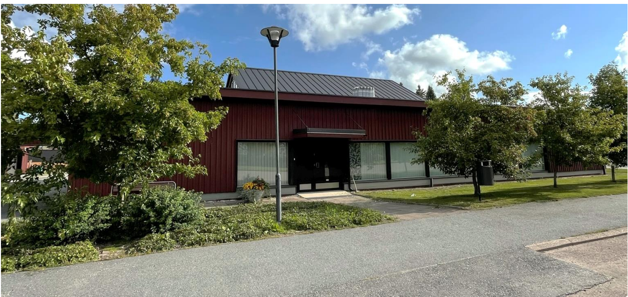
Kuva 4.144. Pääsisäänkäynti A-rakennuksessa ja lasiseinät sen yhteydessä.
