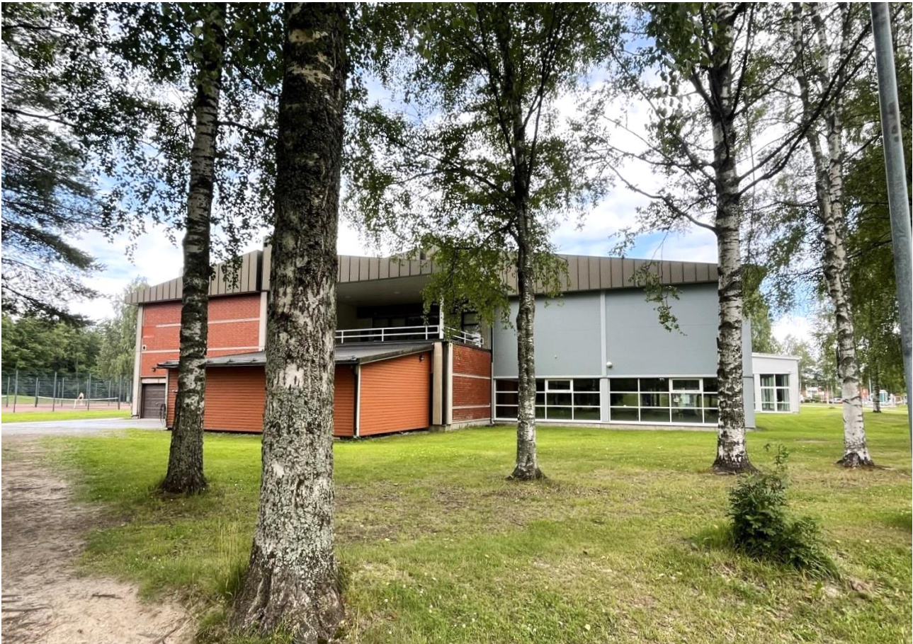
Kuva 4.148. Rakennuksen kaakkoisjulkisivu. Vasemmalla rakennuksen eteen on lisätty ulkova-rasto vuoden 2005 peruskorjauksen yhteydessä. Oikealla uima-altaan osalla julkisivumateriaali on muutettu.
