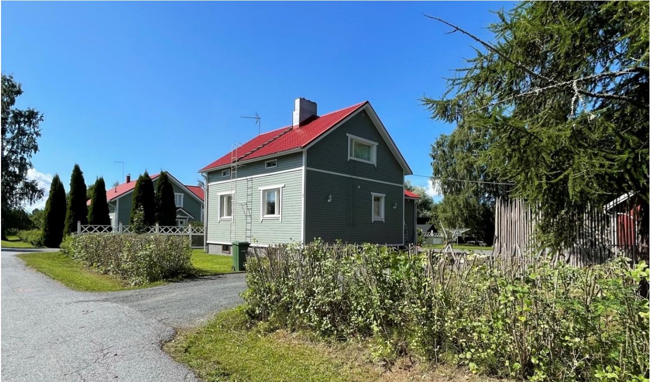
Kuva 4.59. Talo Veljestien pohjoisvarrella. Ikkunat ja puuverhous on uusittu, ikkunakehykset ja verhouksen listat on lisätty, kattomateriaali on muutettu. Kattokorkeuskin on todennäköisesti muutettu alkuperäisestään.
