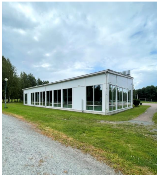
Kuva 4.150. Monitoimialtaan laajennusosa vuodelta 2005, joka on Paroc -elementeillä verhoiltu.
