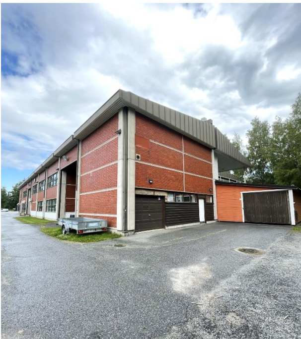
Kuva 4.149. Rakennuksen eteläkulma, jossa alkuperäiset tiilielementit ovat säilyneet. Katotyypä on muutettu harjakatoksi.
