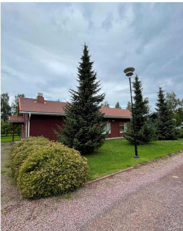
Kuva 4.168. Pohjoispuoleisen rakennuksen eteläjulkisivu pihatielle päin.
