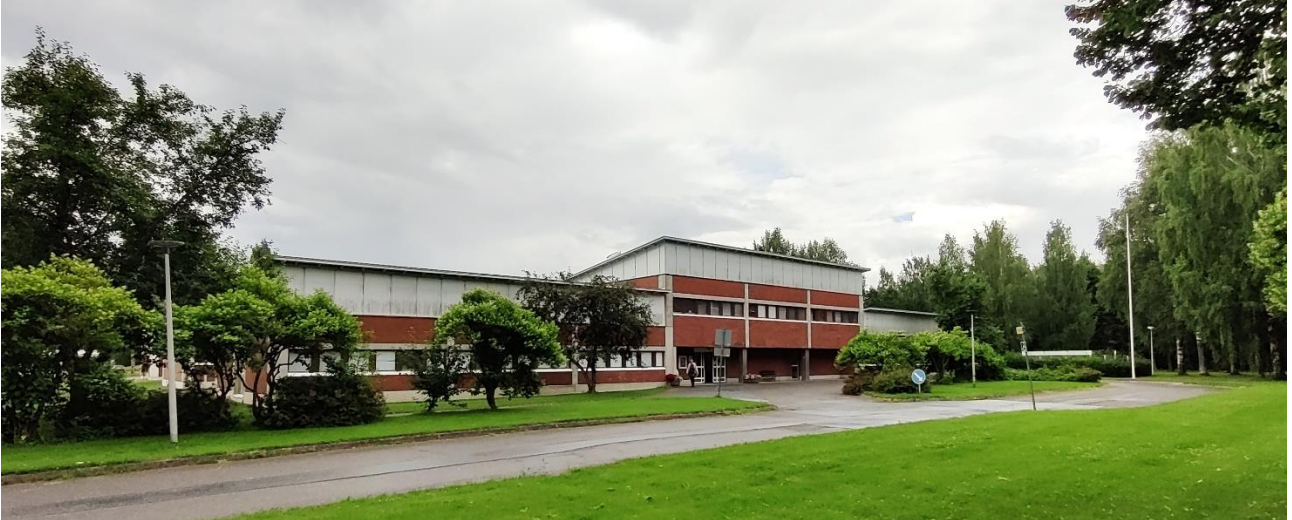
Kuva 4.152. Terveyskeskuksen A-talon julkisivu luoteeseen Siltatielle päin. Keskiosa pohjois- ja eteläsiiven välissä on kaksikerroksinen.
