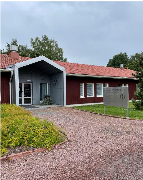
Kuva 4.171. Eteläpuoleisen rakennuksen sisäänkäynti ja sen kehystävä alumiinikasetti-pinta. Myös pohjoispuoleiselle rakennukselle asennettiin tämän tyyppinen katos saneeraus-yhteydessä.
