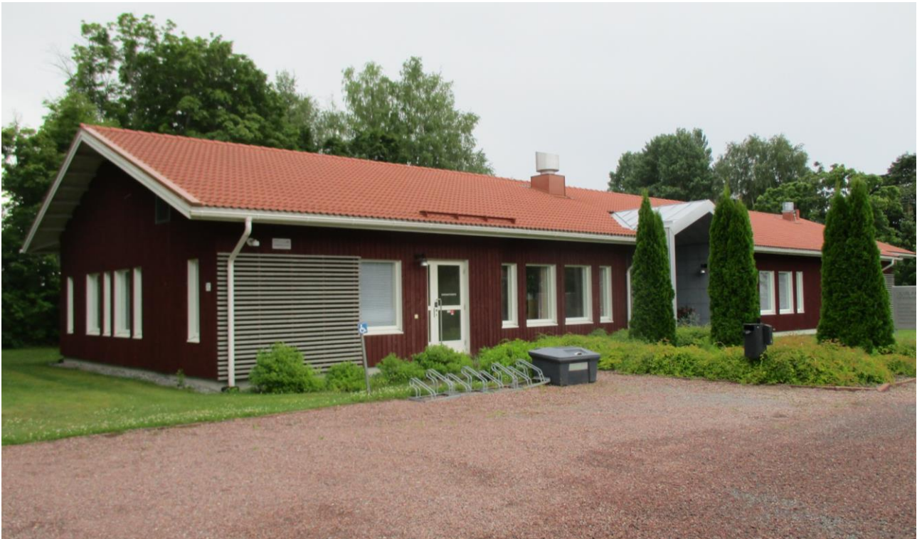
Kuva 4.170. Eteläpuoleisen rakennuksen pohjoisjulkisivu pihatielle päin. Puulaudat on asennettu pystyyn, aukotuksen ratkaisu on 2000-luvulle tyyppillistä.
