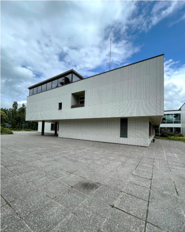
Kuva 4.162. Parveke alkuperäisen siiven länsipuolella.
