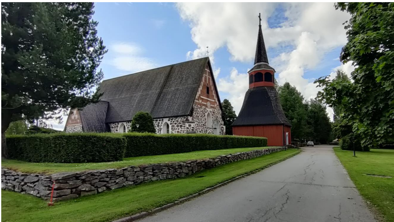
Kuva 3.5. Ulvilan kirkko. Kuva kohdekäynniltä, 2023.
