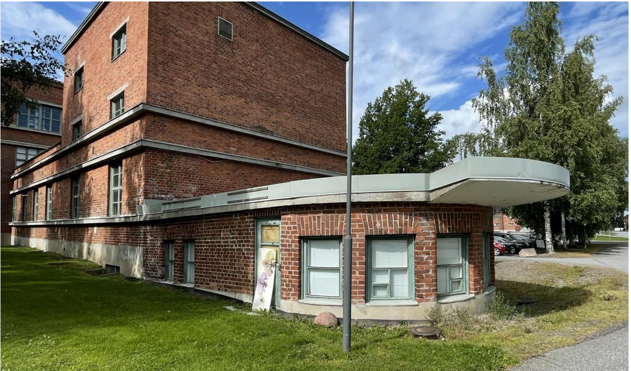
Kuva 3.8. Friitalan tehdas. Matalahko pyöristetty osa sijaitsee rakennuksen eteläpuolella. Kuva kohdekäynniltä, 2023.
