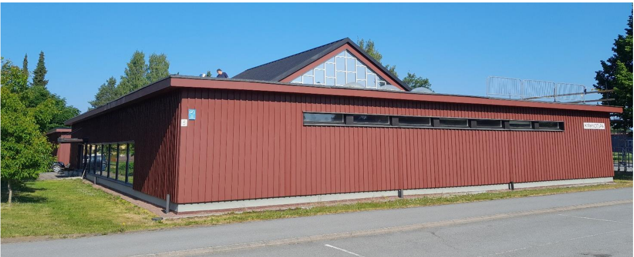
Kuva 4.140. A-rakennuksen julkisivu itään. Sisäpihan katos on toteutettu 1990-luvun alussa.
