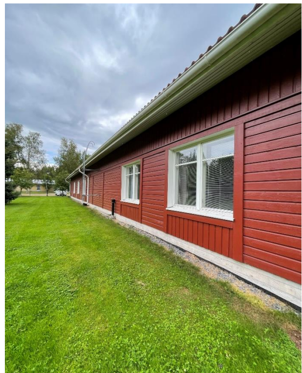
Kuva 4.169. Pohjoispuoleisen rakennuksen pohjoisjulkisivu puutarhalle päin. Julkisivuvuoraus on alkuperäisen suunnitelman mukainen.
