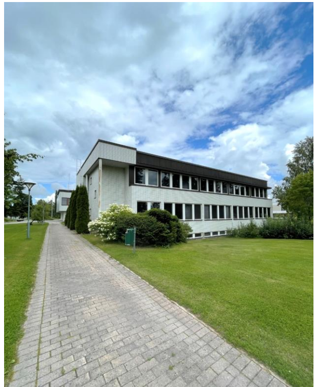
Kuva 4.165. Uuden osan eteläpuolinen julkisivu. Ikkunatyypit ovat erilaisia alkuperäiseen osaan verrattuna.
