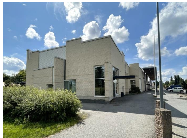
Kuva 4.126. Kirjaston koillispääty lukion puolella. Oikealla paikoitusalue.
