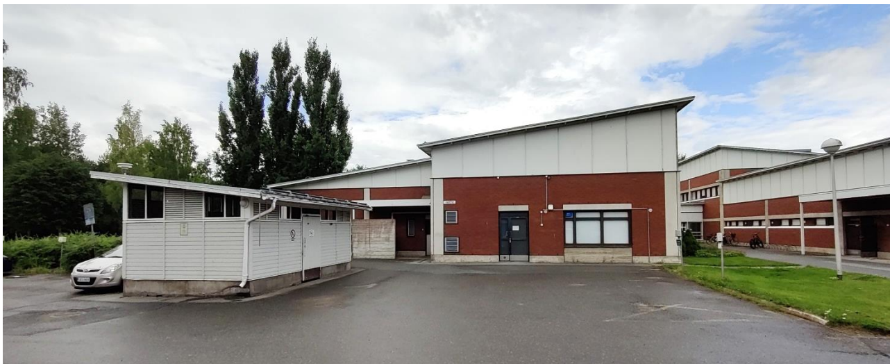
Kuva 4.156. B-talon julkisivu koilliseen. 2000-luvun pulpettikatot ovat merkittävä muutos.
