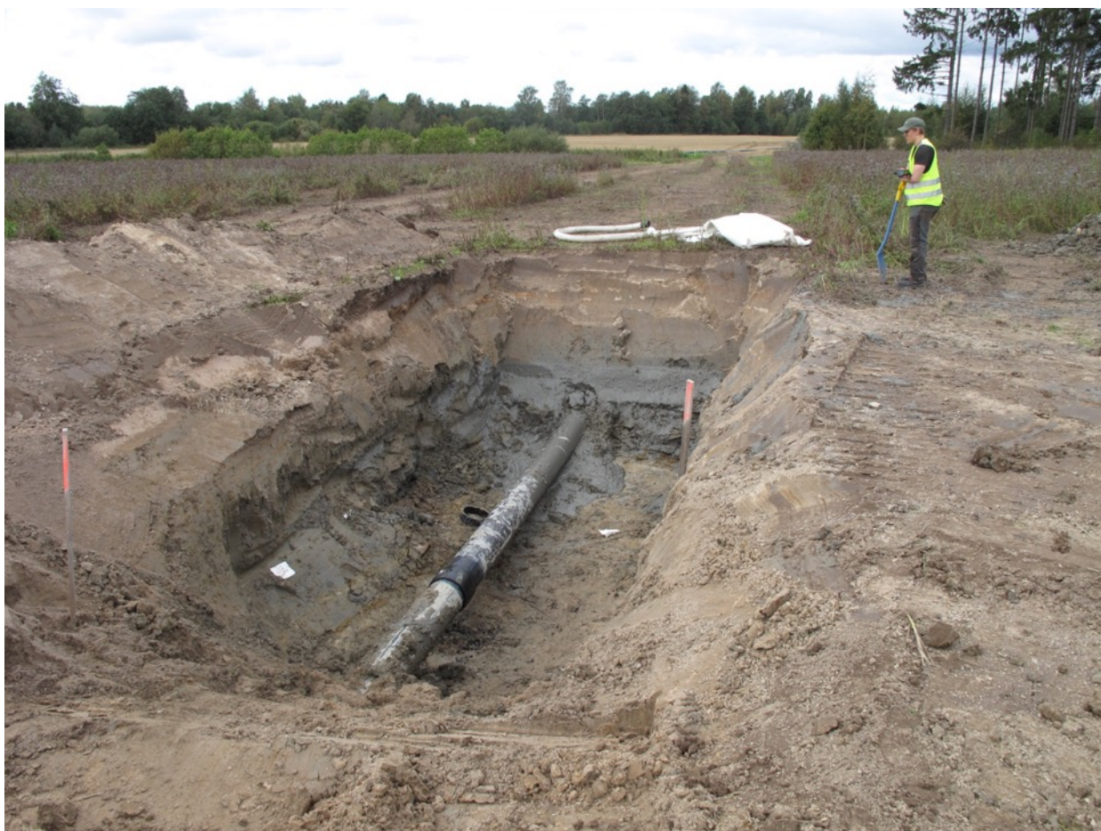
Kuva 60. Vesihuoltolinjan rakentaminen oli muokannut Isokartanon metallinetsinlöytöpaikan täydellisesti. Kuva lännestä, Hannu Takala, Maanala Oy.
